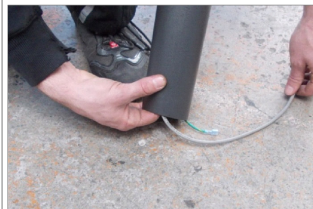
Abb. 10 Montage 4Front, Kabel
