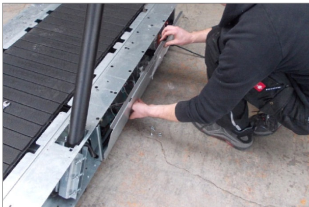
Abb. 28 Montage Mercury/Path, Elektronikabdeckblech
