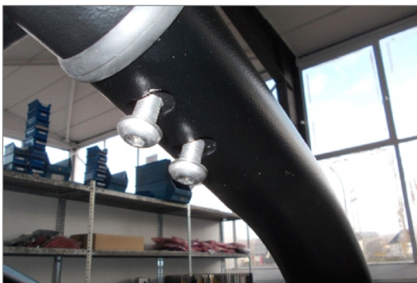
Abb. 33 Montage Pro/ProXL, Geländer verschrauben
