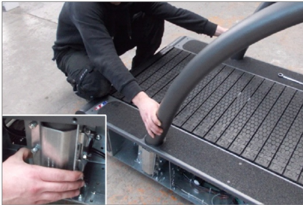
Abb. 12 Montage 4Front, Rohr einstecken
