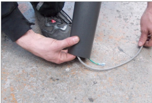
Abb. 10 Montage 4Front, Kabel
